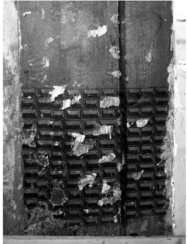
Bad Windsheim, Seegasse 8, Wand zur ehemaligen Küche, Sockelbereich mit aufgedruckten Diamantquadern.
